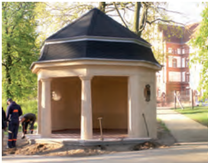
Die denkmalgeschützte Wartehalle am Schleifmühlenweg wurde vor zwei Jahren von den Mitarbeitern der Neumühler Bauhütte restauriert.
