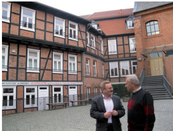
Rudolf Hubert (l.) und Stefan Gillner freuen sich über die gelungene Sanierung des „Langen Jammers“.
