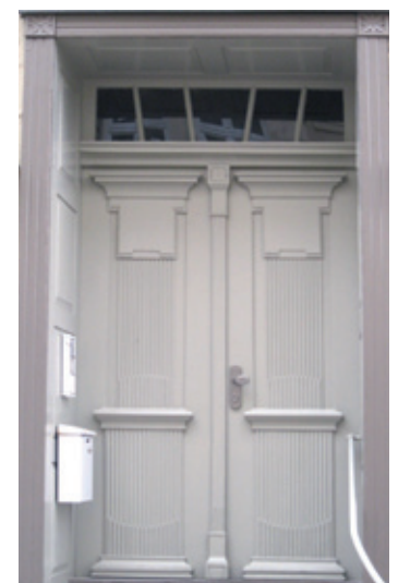
Stilvoll saniert: Die Eingangstür in der Schloßstraße.
