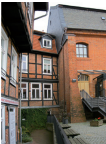
Der Höhenunterschied zum benachbarten Grundstück ist groß.
